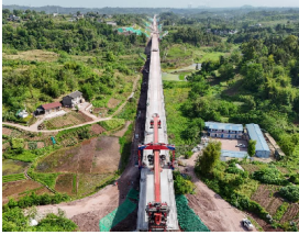
西渝高铁达州至广安段完成架梁
